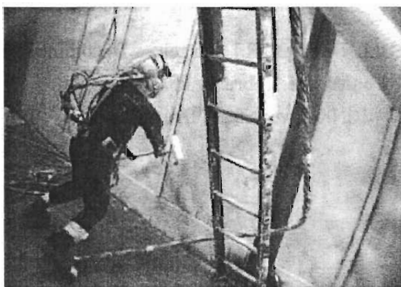
図2 水中での壁面塗装作業
